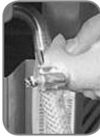
6. Rosqueie a mangueira metálica no registro de gás com o auxílio de duas chaves de boca. Utilize pasta vedante para auxiliar na vedação. O ponto de abastecimento de gás tem que permitir a instalação da mangueira flexível metálica de maneira que ela fique paralela a parede evitando-se assim um estrangulamento.
