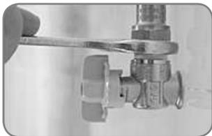
1. Rosqueie a mangueira metálica no registro de gás da parede com o auxílio de duas chaves de boca. O ponto de abastecimento de gás tem que permitir a instalação da mangueira flexível metálica de maneira que ela fique paralela a parede evitando-se assim um estrangulamento.
